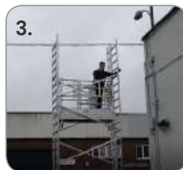
3. Ensamblar el marco lateral
