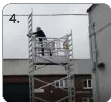
4. Colocar las abrazaderas
