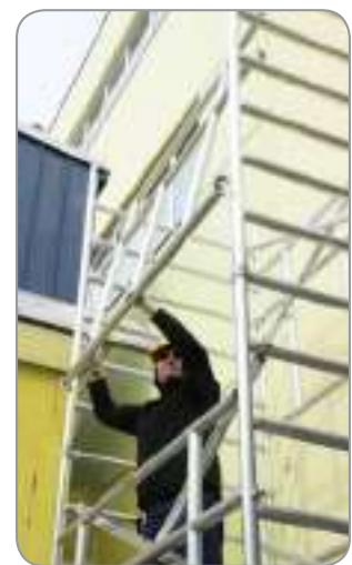
4. Barandillas equipadas con ganchos rápidos
