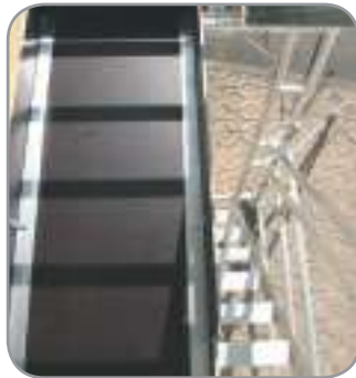
Plataforma intermedia con rodapiés en cada nivel
