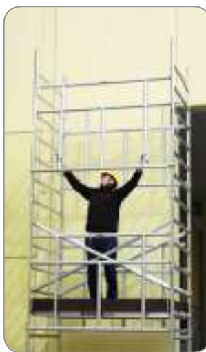
3. El operario está asegurado en todo momento mientras monta el andamio
