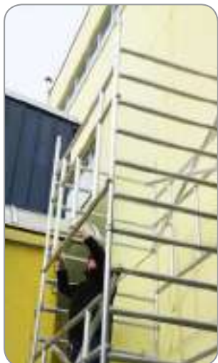
5. Con un simple movimiento las barandillas quedan instaladas en los marcos
